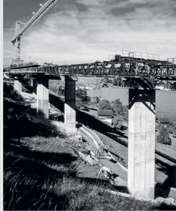
**Brückenpfeiler mit Vorschubgerüst. Total 116 Pfeiler mit bis zu 45 m Höhe ab gewachsenem Terrain. Die Brückenpfeiler sind in der Regel auf Schachtpfeiler aufgesetzt.**
