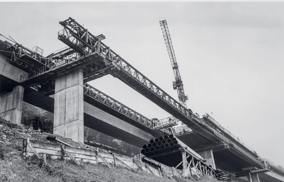
**Im 14-Tage-Takt wird ein Brückenfeld von 55 Meter Länge vorgeschoben und betoniert. 110 solcher Hauptbrücken waren zu erstellen.**
