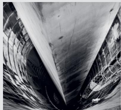
**46 Pfeiler bis zu 59,4 Meter Länge. Abstand von 1,50 m zwischen der Schachtwand und Pfeiler. Stossen Gelenkringe in diesen Bereich vor, erfolgen Massnahmen zum Schutz des Pfeilers.**
