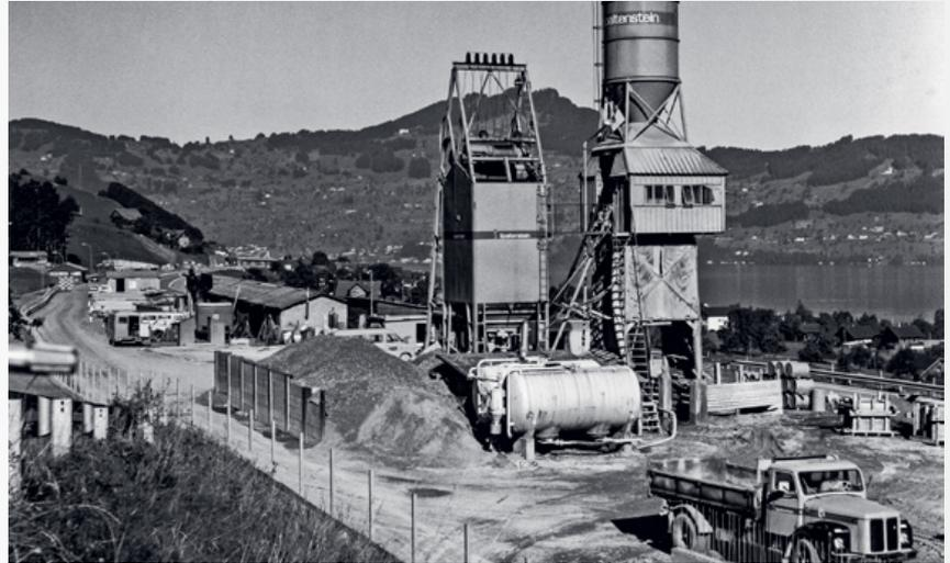
Der Installationsplatz «Höfe» war Dreh- und Angelpunkt für die Arbeiten am Lehenviadukt. Von hier aus wurden über speziell angelegte Zufahrtspisten die einzelnen Baustellen erschlossen und bedient.
