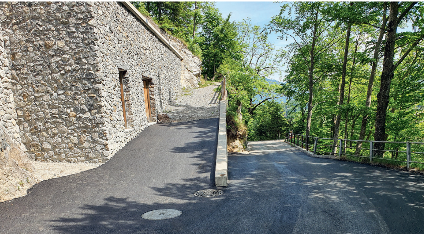
Fertiger Asphalt vor Reservoir
