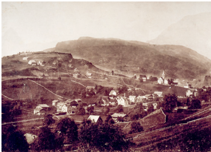
Alte Kirche und Bau des Egg-Schulhauses
