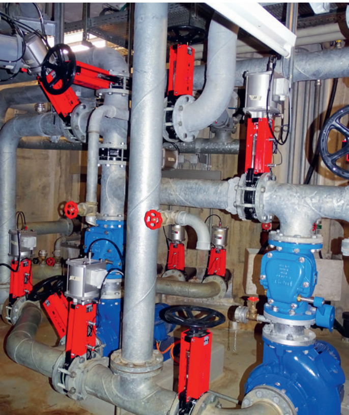
Ersatz Schieber Faulanlage
