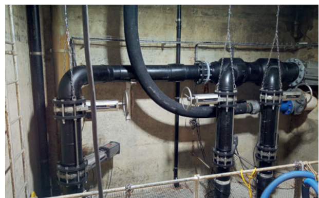
PW Hobiel Sanierung Pumpwerk
