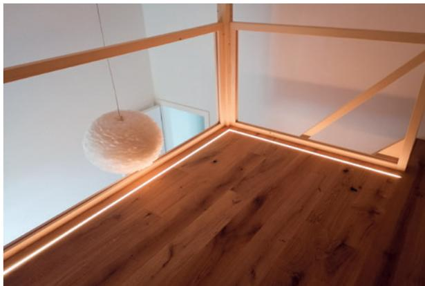
**LED-Einbau in Galerieboden**
