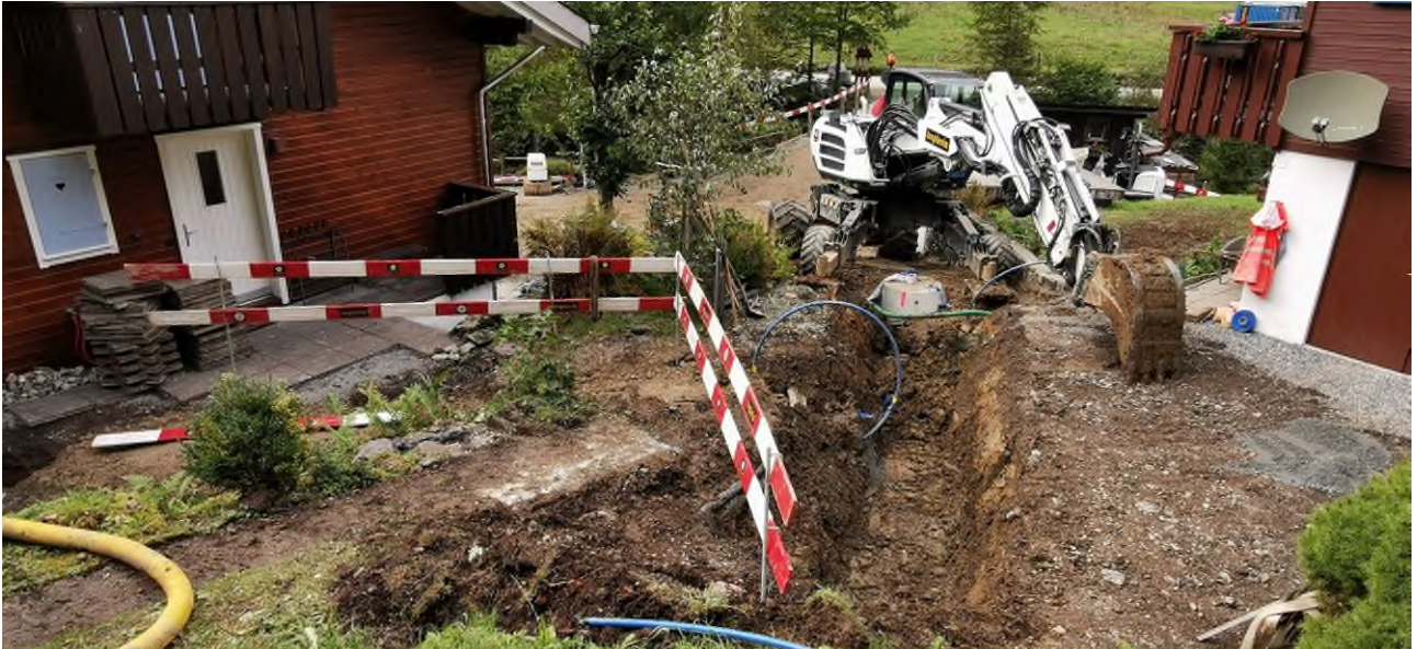
Abb.: Bauarbeiten Stärten, Grabarbeiten Leitungsbau
