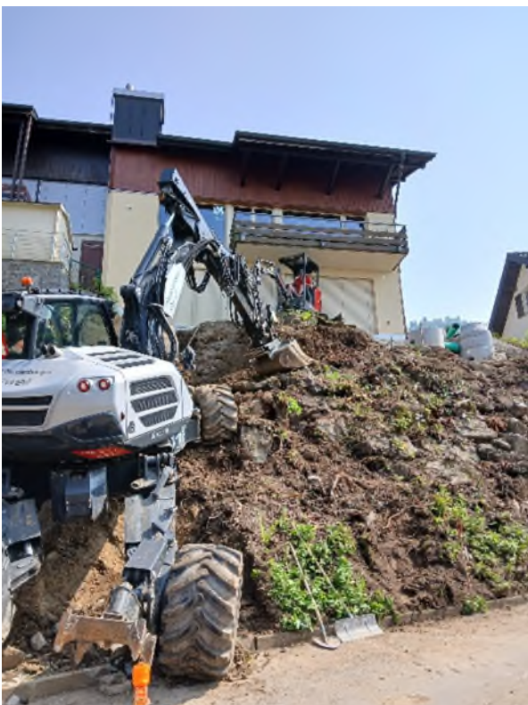
Abb.: Baggerarbeiten Abgrabungen
