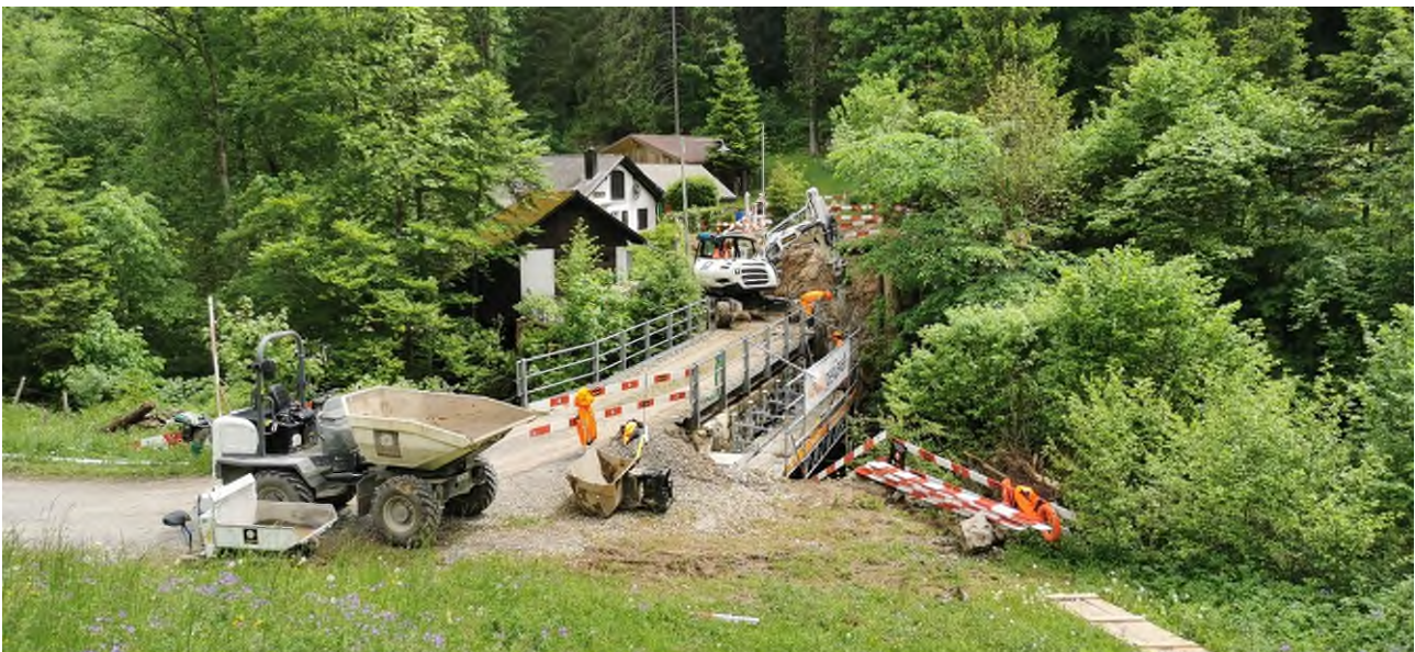
Abb.: Bauarbeiten Stärten, Grabarbeiten Pumpschacht und Brücke
