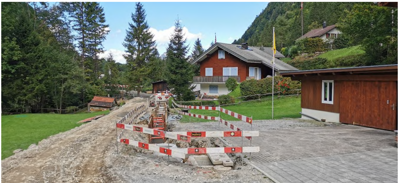
Abb.: Bauarbeiten Stärten, Grabarbeiten Leitungsbau
