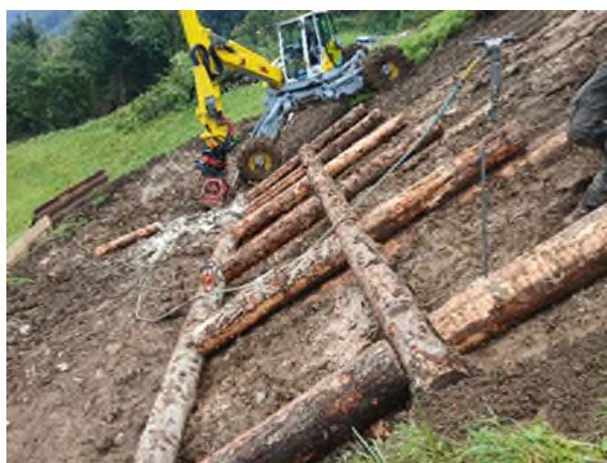
Abb.: Holzkasten Schutz der Strasse Zufahrt für Dämme/Sammler Saumwald
