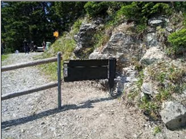
Abb. 21: Twäregg. Selbstschliessendes Weidezauntor (Flowgate) neu montieren
